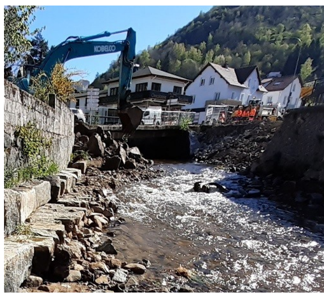
➤ La Bresse : arasement de seuil (aval du pont des Champions)
