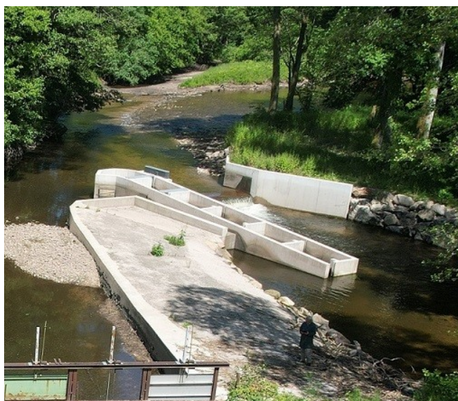
➤ Beauménil : aménagement de la prise d'eau et dispositif de dévalaison
